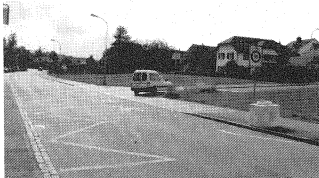
Einfahrt Moosstrasse – Fislisbacherstrasse
