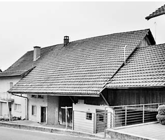
Auf diesem Abschnitt der Kirchgasse geschah der Lehrermord. Hier stand 1881 ein Strohdachhaus, aus dessen Stubenfenster der tödliche Schuss abgegeben wurde. (Foto Peter Züllig).
