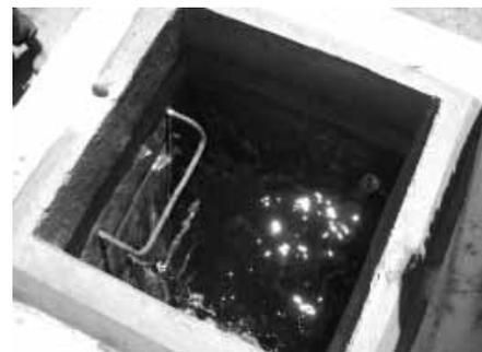
2010 und 2011 gelang es dem Verein, drei weitere Wasserversorgungen zu erstellen. Eine Betonkonstruktion fängt das Quellwasser ein, anschliessend wird es durch einen Sandfilter geleitet und gereinigt und gelangt dann durch eine lange Wasserleitung zum Weiler.
