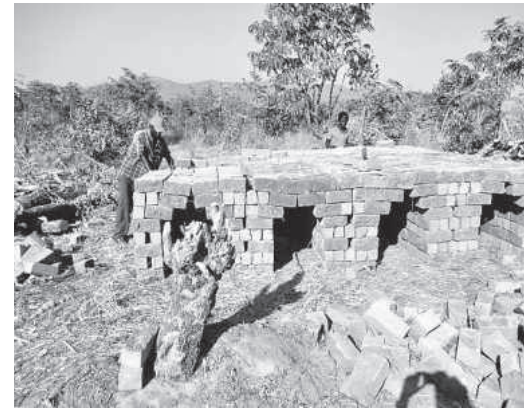
Bau Brennofen
