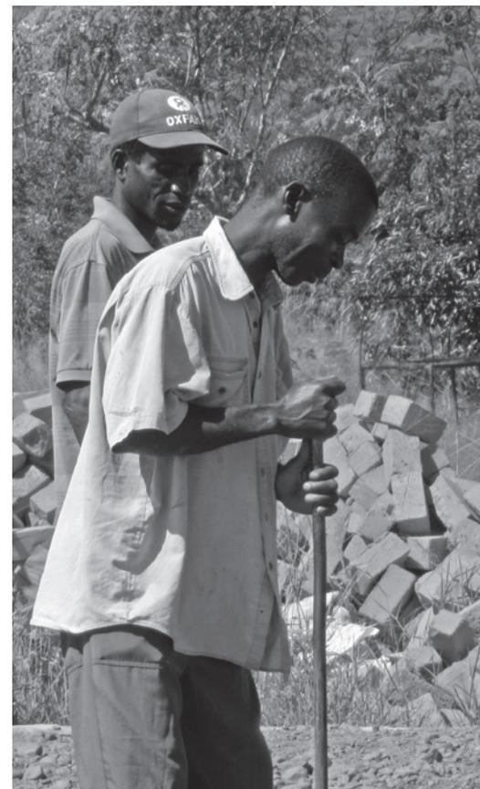
Alles wird hier von Hand gemacht, denn es gibt keinerlei Maschinen: Die Füllung des Fundamentes (v.a. zerbrochene Backsteine und Kies) wird in anstrengender Handarbeit verdichtet, bevor der Zement darüber gegossen wird.
